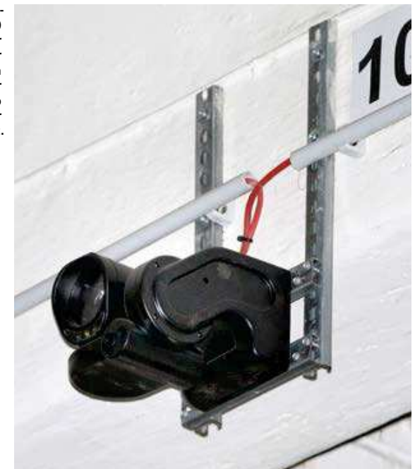
In den Produktionshallen (oben) wurden Sender und Empfänger der linienförmigen Rauchmelder (rechts) unterhalb der Wärmepolster installiert.
