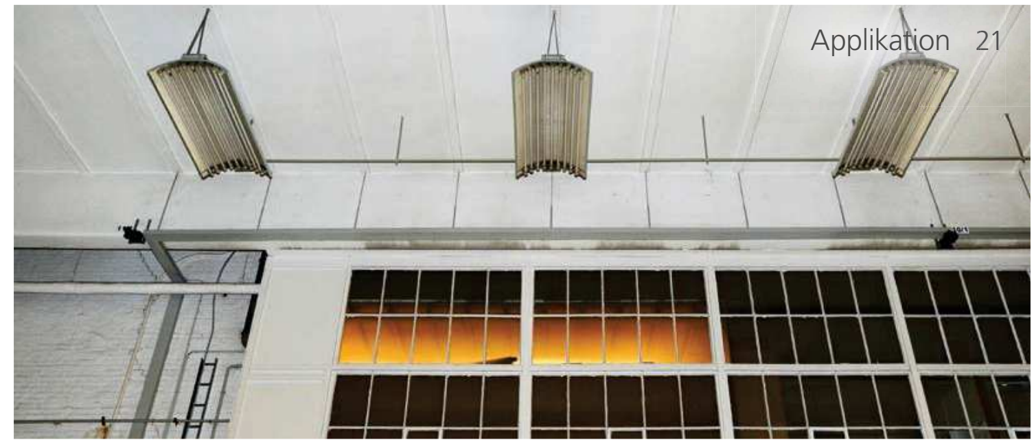
In den Produktionshallen (oben) wurden Sender und Empfänger der linienförmigen Rauchmelder (rechts) unterhalb der Wärmepolster installiert.
